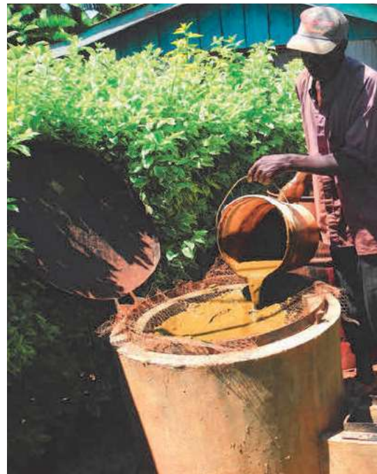
Befüllen einer Biogasanlage in Indien.
