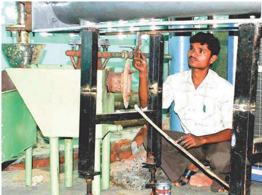
Biomasse-Kraftwerk in Bhebhra, Indien.
